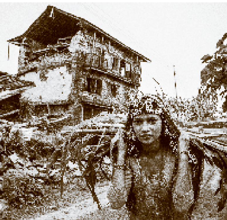
Susila Bora, 19, Saurpani-4 Dorf, das zerstört wurde, als im April 2015 ein Erdbeben der Stärke 7,8 Nepal erschütterte Foto © Panos Pictures/Vlad Sokhin
